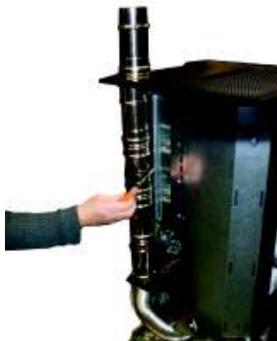
Fig. 28 - Posicionamiento superior de los tubos
