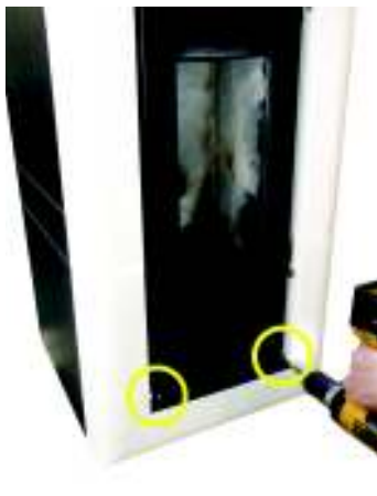
Fig. 19 - Fijación marco
