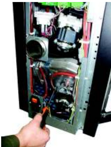
Fig. 58 - Limpieza del aspirador de humos: fase 1
