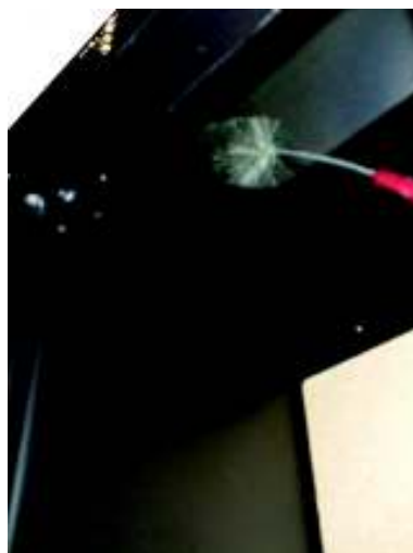
Fig. 51 - Limpieza con escobilla 1
