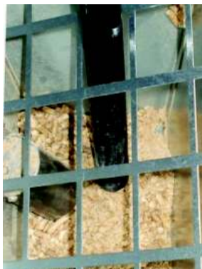
Fig. 43 - Limpieza depósito y coclea
