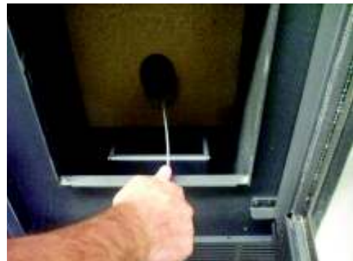
Fig. 42 - Limpieza con escobilla
