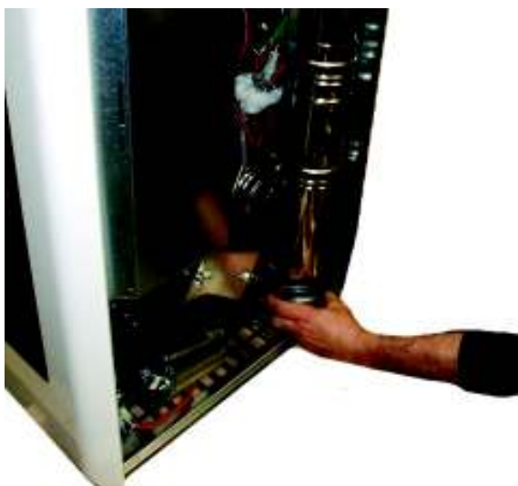
Fig. 56 - Limpieza canal de humos
