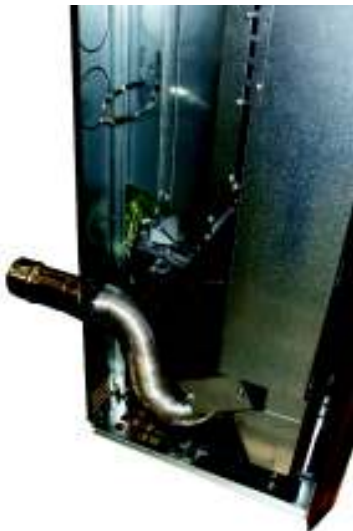
Fig. 30 - Posicionamiento posterior de los tubos
