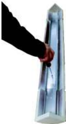
Fig. 21 - Atornille el perfil en las mayólicas
