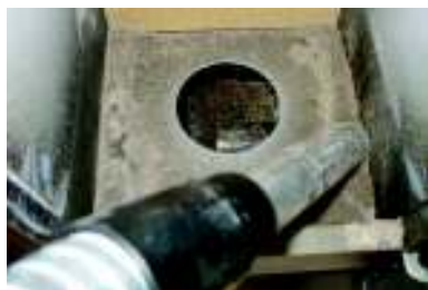
Fig. 36 - Limpieza alojamiento cajón de cenizas
