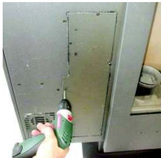
Fig. 41 - Extracción panel de inspección
