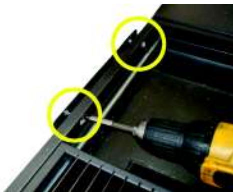
Fig. 16 - Fijación en pared
