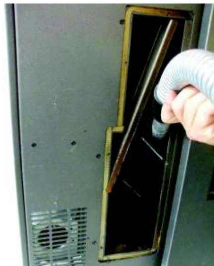
Fig. 43 - Limpieza cámara de humos
