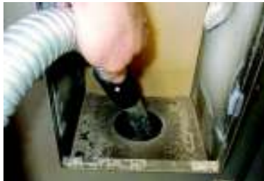
Fig. 37 - Limpieza alojamiento brasero
