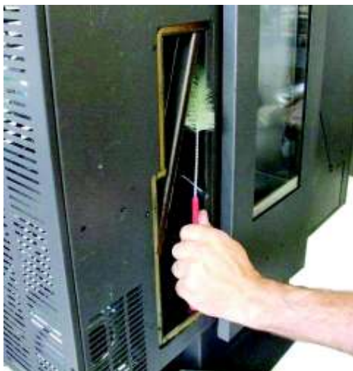
Fig. 42 - Limpieza con escobilla
